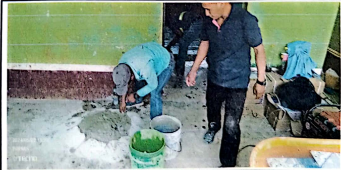
Foto 6: Continuación de colocación del piso cerámico de la EORM Aldea Setzacpec
