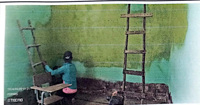
Foto 3: Inicio del cambio de pintura de la EORM Aldea Setzacpec
