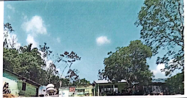
Foto 2: Seguimiento de cambio de entechado de la EORM de la Aldea Setzacpec.
